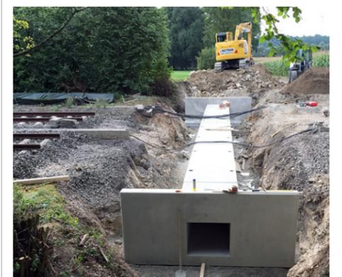
Anschließend wurden die Baugruben wieder verfüllt und der Gleisoberbau wieder hergestellt. Im Anschluss der Totsperrung folgten die Nebenarbeiten, wie z.B. die Montage der Geländer und Anpassungsarbeiten im Bereich der Ein- und Ausläufe. Aufgrund der zeitlich kurz gehaltenen Streckensperrung mussten die Arbeiten rund um die Uhr im Mehrschichtenbetrieb ausgeführt werden.
