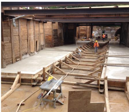
Seit Februar 2016 ist eine Kolonne unter dem Polier U. Schneider der Ingenieurbauabteilung aus Hamm im 300 km entfernten Darmstadt-Kranichstein tätig. In den letzten Monaten wurde hier eine vorhandene Eisenbahnüberführung über den Ruthsenbach abgebrochen und ein neuer Stahlbetonvollrahmen in Ort betonbauweise hergestellt.
