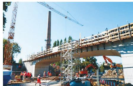
Ungewöhnliche Forderungen nach geringen Fertigungstoleranzen bei der Herstellung der Gründungsebenen und für die Verspannung der beiden Widerlager während des Verschiebes waren Besonderheiten des schiefwinkligen Rahmenbauwerkes mit 26 m Stützweite.
