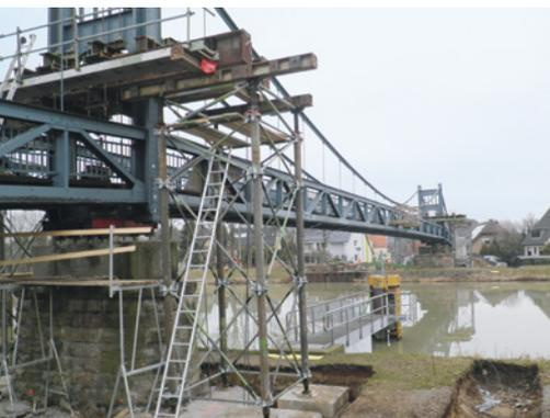
**Schulwegsteg über den Datteln-Hamm-Kanal, Hamm** – Hebung und Sanierung des unter Denkmalschutz stehenden Fußgängerstegs nahe der Schleuse Werries, einschließlich der Erneuerung des Korrosionsschutzes
