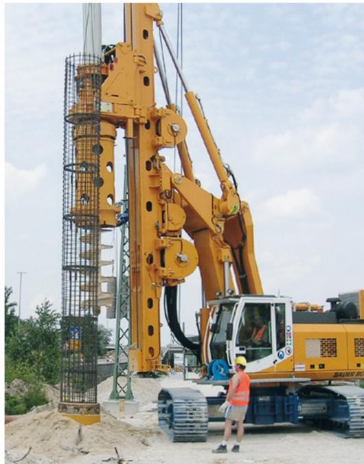
Bohrkolonne beim Einheben eines Bewehrungskorbes
