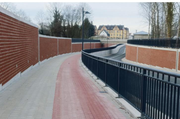
Ansicht des fertigen Projektes, BÜ-Beseitigung Südertor, 1. Bauabschnitt, Lippstadt – Erbrachte Leistungen: Neubau einer Eisenbahnüberführung, zwei Regenrückhaltebecken, ein Straßentrog, eine Pumpenstation, Straßenbau und Lärmschutzwände
