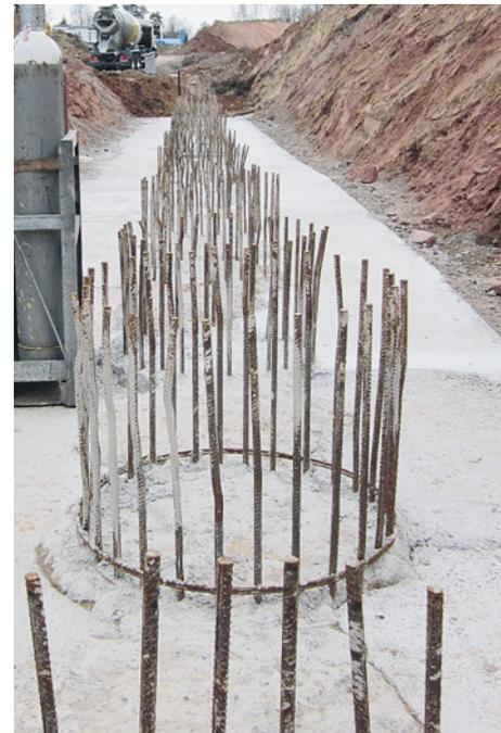
Fertige Bohrpfähle mit Anschlußbewehrung
