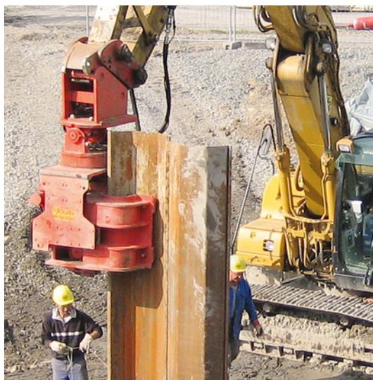
Spundwanddrammung mit Seitenramme (Movax SP-50E) an Raupenhydraulikbagger
