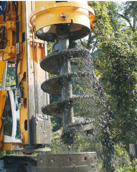
Herstellung eines Bohrpfahls im Kelly-Bohrverfahren
