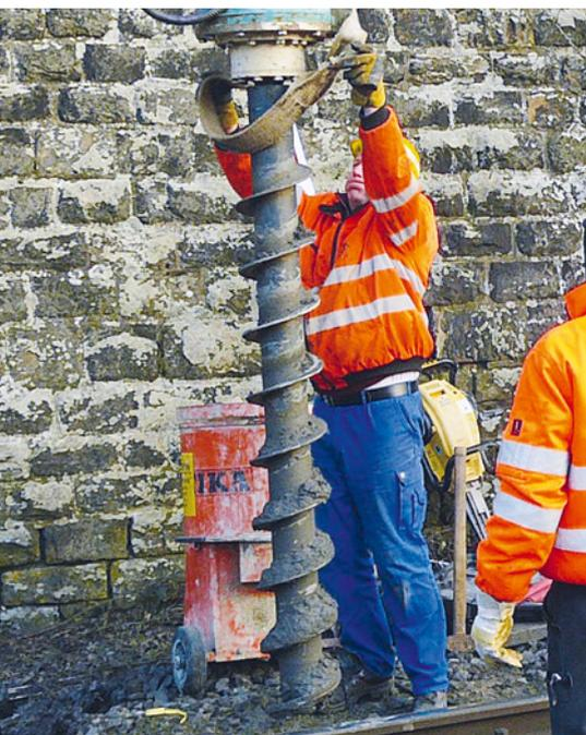
Bohrschneckeneinsatz als Entspannungsbohrung zur Vorbereitung eines statischen (erschütterungsarmen) Eindrückens von vier Stahlrohren bis 6 m Länge im Zuge der Tiefengründung und Montage eines Signalmastes
